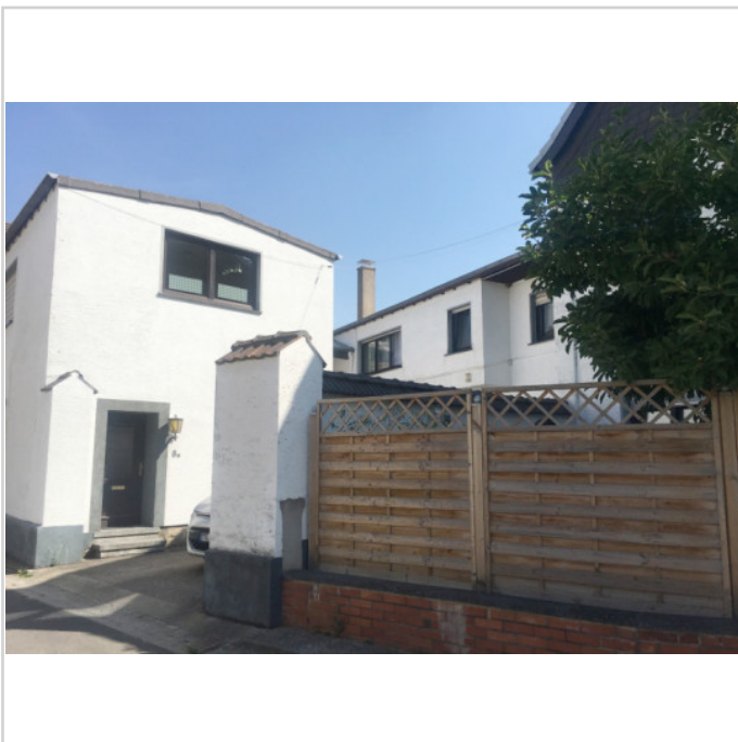
Zufahrt zum Innenhof
